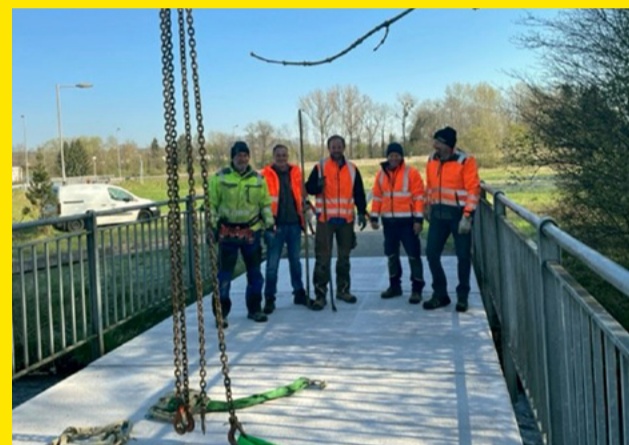
Brücke über den Schwanbach wurde erneuert
